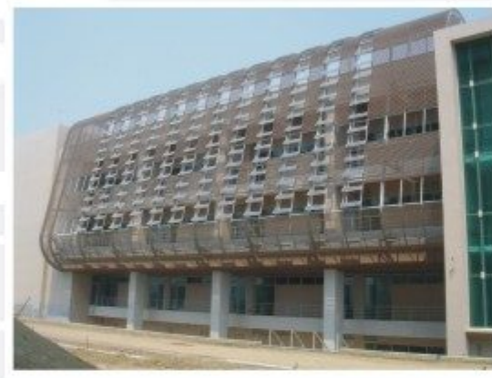
案名：台南環保園區新建大樓 鋼構工程 地點：台南縣 設計：曾永信建築師事務所 營造：嘉榮營造股份有限公司
