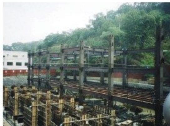
案名：台電龍梅變電站 鋼構工程 地點：竹科 設計：正堯結構顧問公司 營造：瑞助營造
