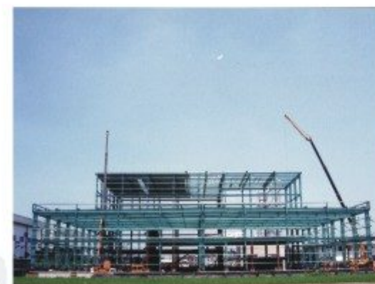
案名：台寶新豐廠 鋼構工程 地點：新竹新豐工業區 設計：吳明修建築師事務所
