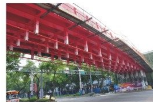
橋面與預力鋼棒安裝連接安裝
