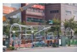
橋體分段地面組立 -1
