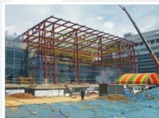
案名：合勤科技活動中心 造型鋼構工程 地點：竹科 設計：潘翼聯合建築師事務所 營造：富泰營造
