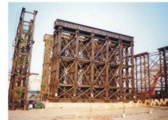
案名：高鐵C250橋樑臨時支撐 鋼構工程 地點：台中烏日 營造：日商川田橋樑股份有限公司
