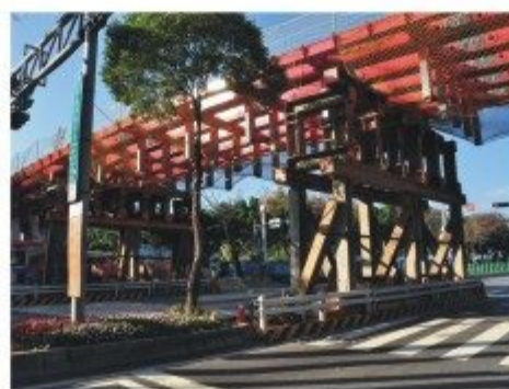
橋面連接安裝
