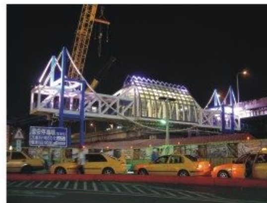
案名：高雄人行陸橋鋼構工程 地點：高雄市 設計：中興工程顧問公司 營造：清水建設
