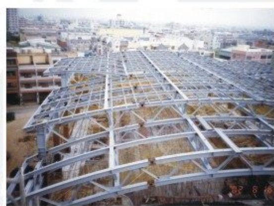
案名：爽文國中體育館 鋼構工程 地點：台中 設計：譚一川建築事務所 營造：益輝營造
