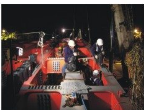
接合板與高張力螺栓安裝
