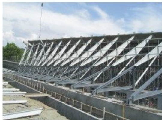
案名：921地震教育園區一期-造型鋼構工程 地點：台中霧峰 建築設計：大涵學乙設計 結構設計：渡邊邦夫+SDG 營造：港洲營造
