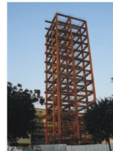
案名：亞記13樓集合住宅-鋼構工程 地點：台北內湖 設計：章聖雄建築師事務所 營造：亞記營造工程股份有限公司
