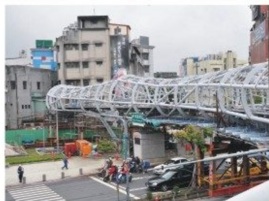
案名：府中人行陸橋 鋼構工程 地點：台北板橋 設計：廖偉立建築師事務所 營造：鴻華營造 結構設計：富田結構設計事務所
