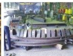
鋼板柱墩加工
