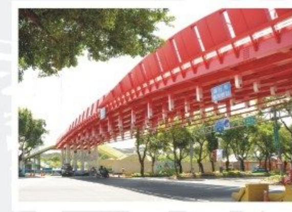
案名：酒泉街橋 鋼構工程 地點：台北 設計：林同棧工程顧問股份有限公司 營造：新高建設股份有限公司
