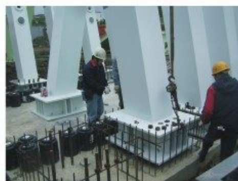
造型方柱安裝
