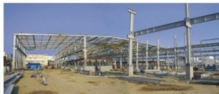
案名：台暉官田二場廠房新建工程 地點：台南縣官田鎮 設計：吳瑞榮建築師事務所 營造：億達營造工程股份有限公司
