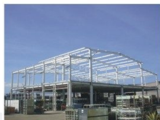
案名：全興工業內埔二廠廠房新建工程 地點：屏東縣內埔鄉 設計：張晏修建築師事務所 營造：強安營造
