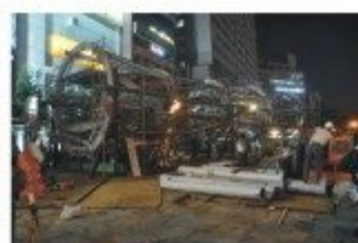
橋體分段地面組立 -2
