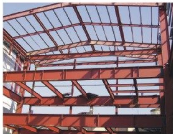
案名：美利達廠房新建工程 地點：彰化大村 設計：林國治建築師事務所 營造：強安營造
