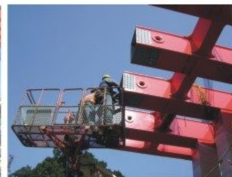
箱樑閉合高空作業
