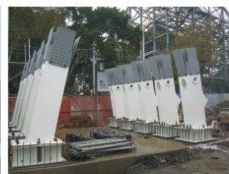
造型方柱安裝完成
