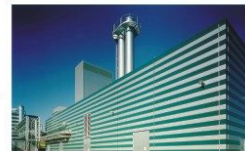
科技工業廠房專業
