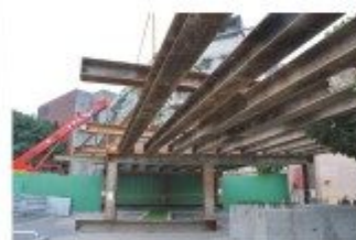
重型支撐平台搭設
