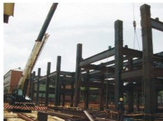
案名：台電楊梅變電站 鋼構工程 地點：楊梅 設計：正堯結構顧問公司 營造：瑞助營造
