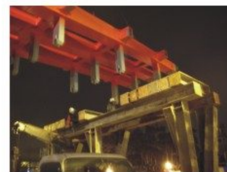
重撈安裝調整
